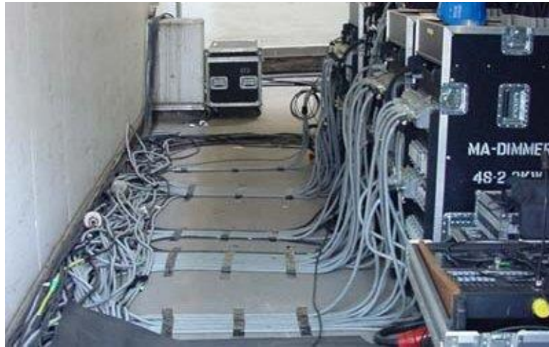
Resim 3.9: Dimmerler ve dimmer odası
