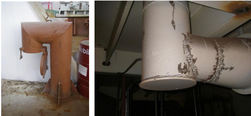
Resim 1.2: Manika havalandırma bağlantı kanalı
