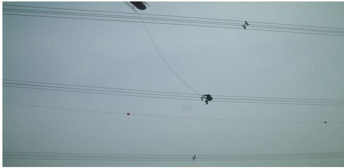
Resim 2.9.b: Spacer (ara parçası) montajı
