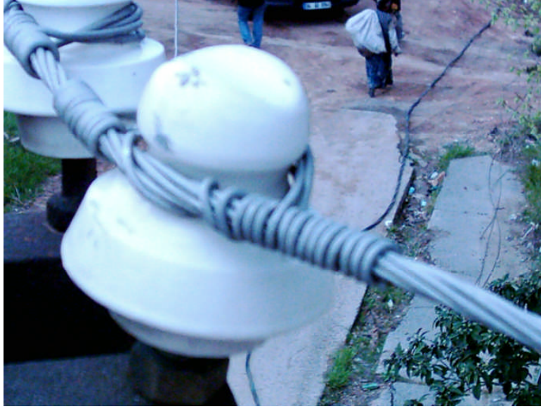
Resim 2.17: İletkenin izolatöre bağlantısı
