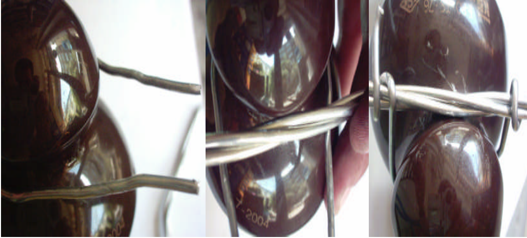
Resim 2.16: İletkenin izolatöre bağlantısı
