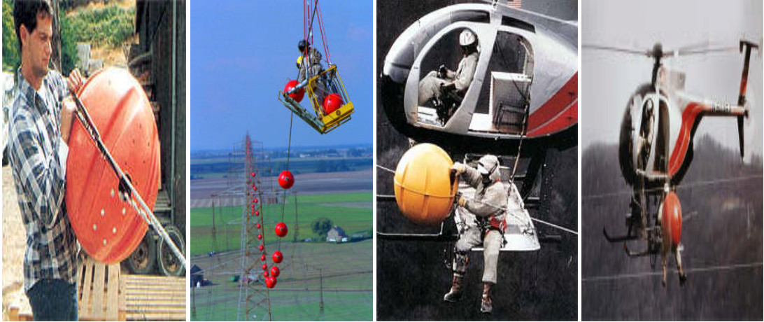
Resim 2.3: Renkli ikaz küresi ve koruma iletkenine takılması
