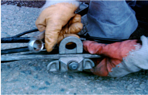
Resim 2.14 a: Alpek (Yalıtılmış alüminyum iletken) çekilmesi
