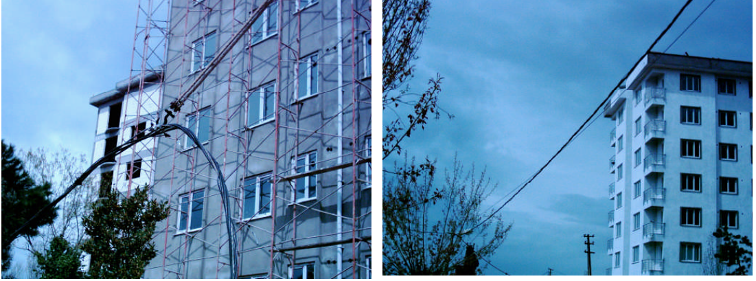
Resim 2.14 b: Alpek kablonun gerdilmesi ve sehimin verilmesi
