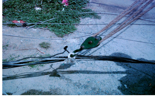
Resim 2.14 a: Alpek (Yalıtılmış alüminyum iletken) çekilmesi
