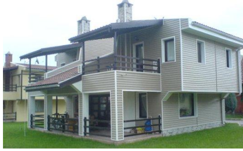
Resim 2.6: Dış cephe yalıtımı
