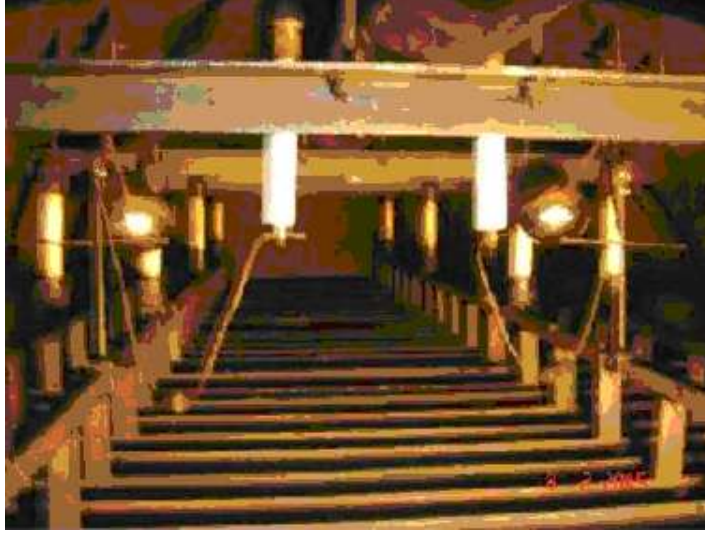
Resim 2.3: Su, petrol ve tuzun elektrik iletkenliklerinin farkıyla titreşim yaptırarak ayrışımını sağlayan saçakların olduğu desalter'ler
