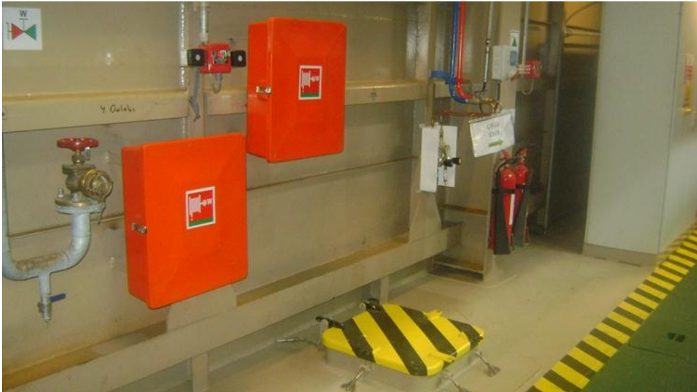
Resim 2.2: Yangın dolabı
