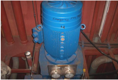
Resim 2.1: Normal yangın pompası
