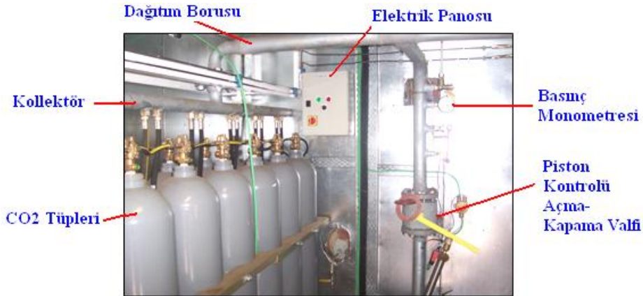
Resim 1.2: Gazlı söndürme sistemi
