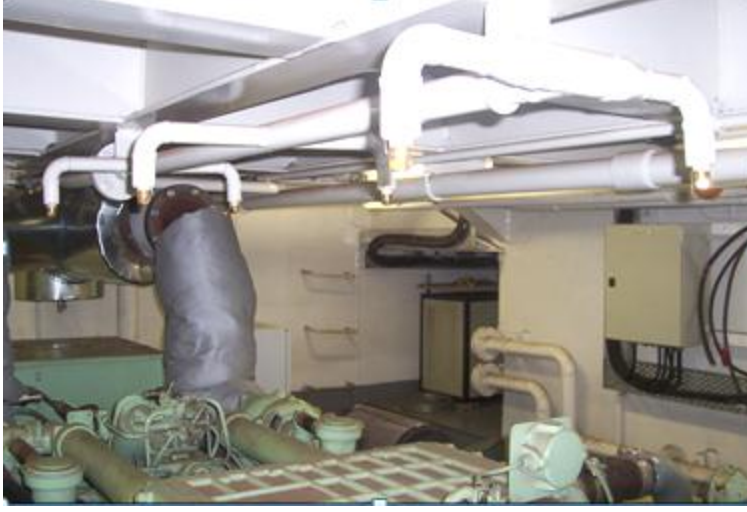
Resim 2.3: Makine dairesi yangın bağlantısı
