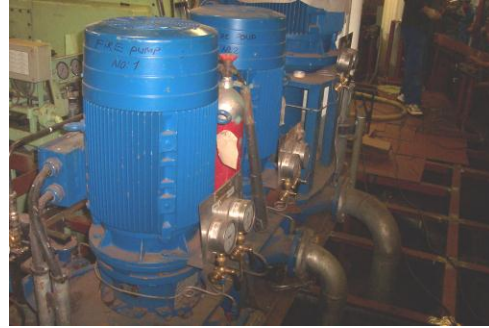
Resim 2.2: Acil durum yangın pompası
