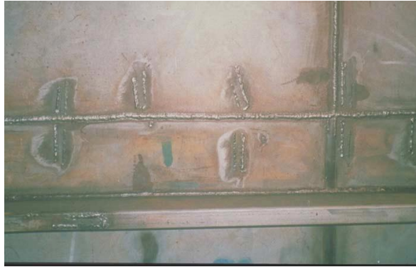
Resim 2.11: Taşlanmadan önce kaynaklı birleştirmenin durumu
