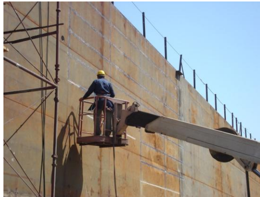
Resim:2.9: Kaplamanın dıřtan kaynatılıřı
