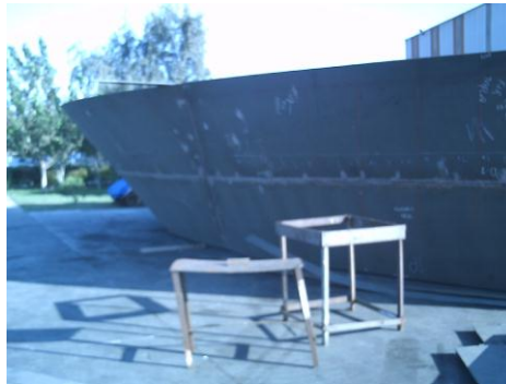
Resim 1.1: Gemi burnuna dış kaplama sacının yerleştirilmesi
