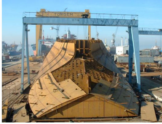
Resim 2.8: Kıç blok kaplamasının yapılıřı
