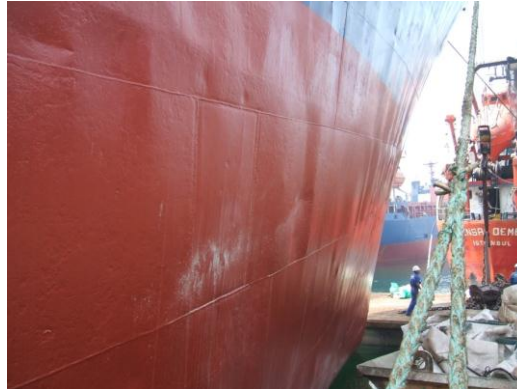
Resim 2.13: Yüzey temizliği yapılarak boyanmış dış kaplama
