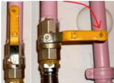
Resim 2.19: Doğalgaz vanasının açık ve kapalı konumu
