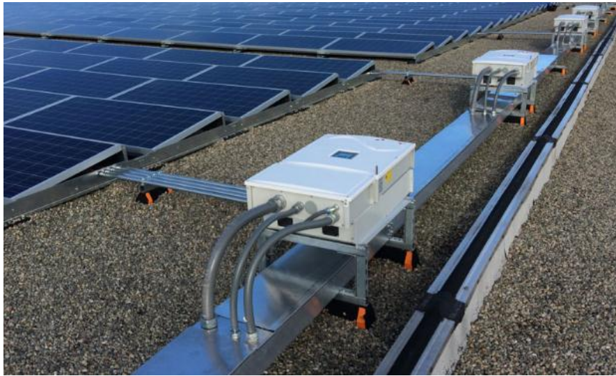
Resim 2.1: Panolar arası kablo montajı
