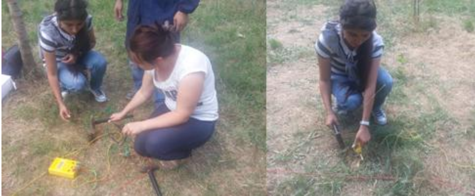
(a) Topraklama çubuğunun çakılması (b) Birinci topraklama çubuğunun çakılması
