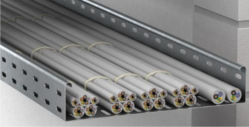
Resim 2.2: Kanala uygun şekilde sabitlenmiş kablolar
