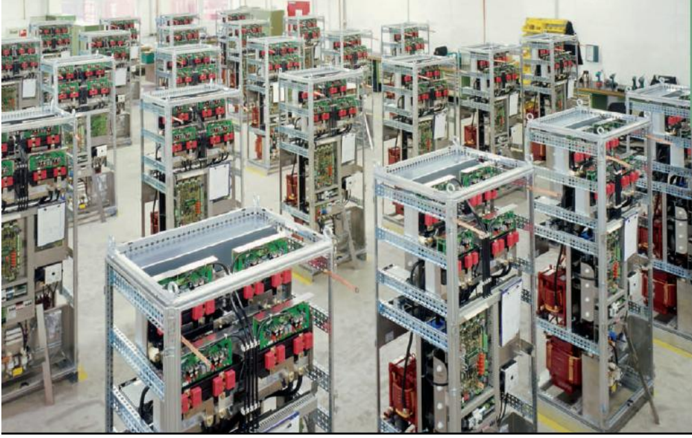
Resim 2.3: Demonte güç panoları
