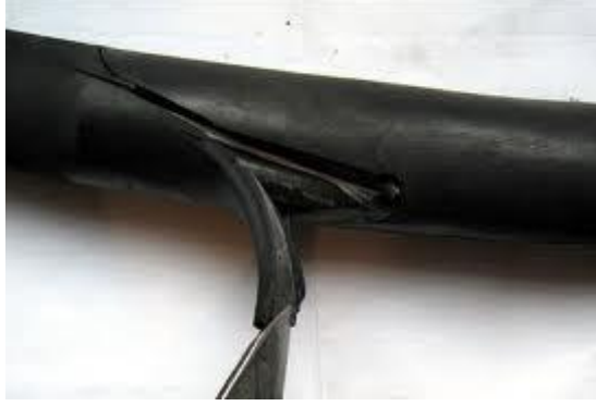
Resim 2.7: Kablolarda izalasyon sorunları
