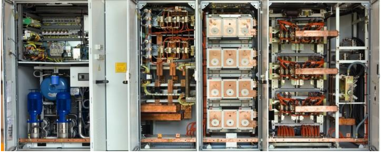
Resim 4.1: Güç ünitesi genel görünüm
