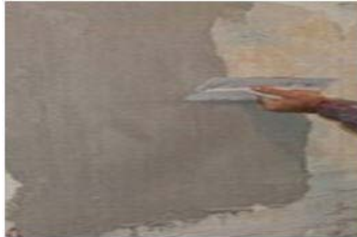
Resim 2.5: Duvara 2.kat sıva yapılması
