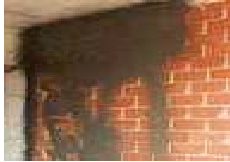
Resim 1.4: 1.Kat sıvanın yapılması
