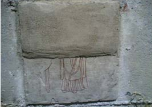
Resim 1.12: 3. kat sıvanın yapılması
