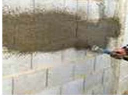
Resim 2.4: Duvara 1.kat sıva yapılması
