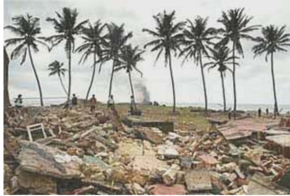
Resim 6: Tsunami'nin kıyıda yarattığı hasar
