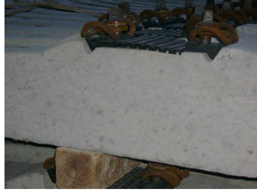
Resim 1.4: Traverste takoz uygulaması
