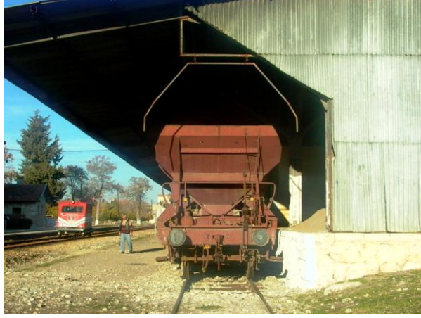
Resim 2.2: Gabari tesisi (yapı)
