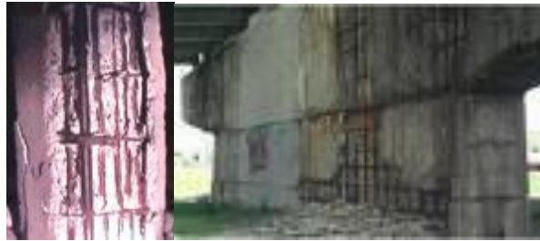
Resim 2. 7: İyi izole edilememiş taşıyıcılar
