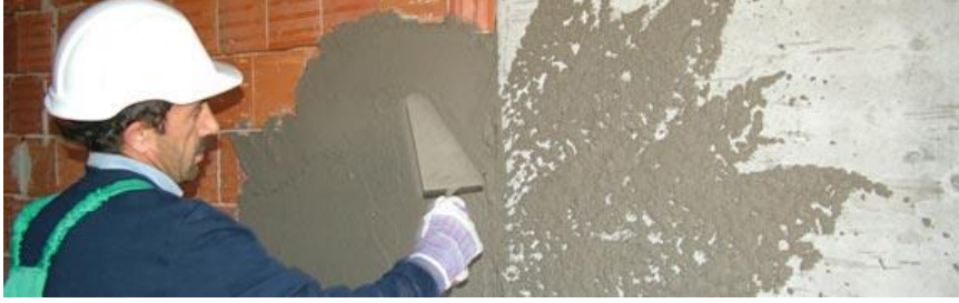
Resim 2. 8: Sıva yüzey oluşturan usta
