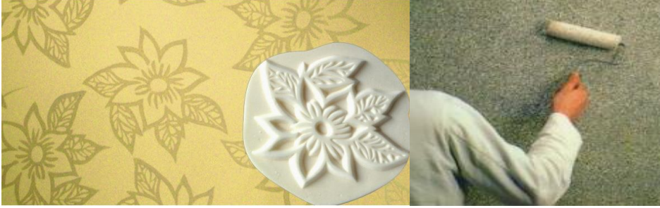
Resim 3. 4: Tampon ve rulo resim uygulama
