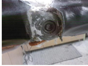
Resim 2.4: İzole edilen eklem yerlerinin temizlenmesi
