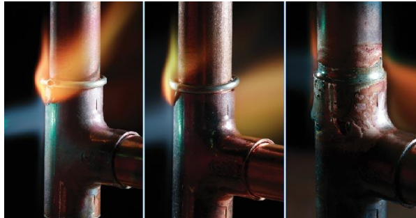
Resim 6.1: Bir borunun sert lehimle birleştirilmesi
