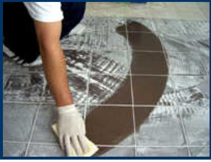
Resim 3.16: Zemin derz dolgu işleminde ilk silme
