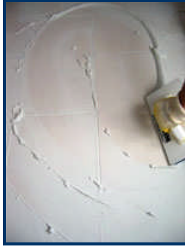
Resim 3.13: Zeminde derz dolgunun yapılması
