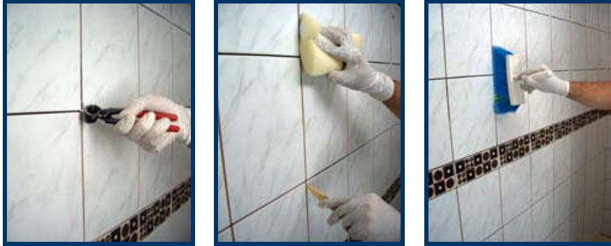
Resim 1.4: Derzlerin duvarda kerpeten, sünger, kama ve fırça ile temizlenmesi
