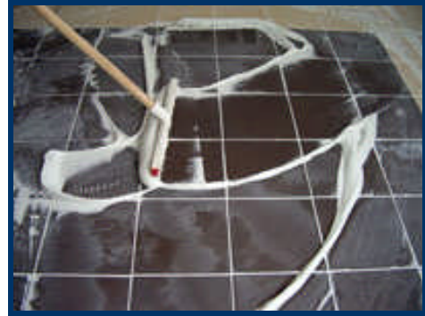
Resim 3.15: Çekpas ile derz dolgu uygulaması
