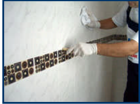
Resim 3.10: Uçuk renk tabakasını tekrar silme ve derzleri oluklandırma
