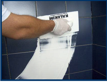
Resim 3.8: Duvarda derz dolgu uygulaması
