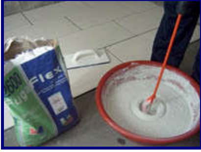
Resim 2.4: Harcın ıslatılması
