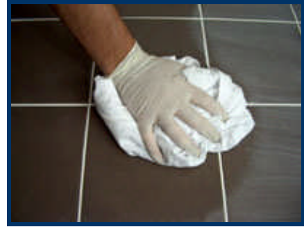
Resim 3.17: Zemin derz dolgu işleminde son silme ve oluklandırma işlemi
