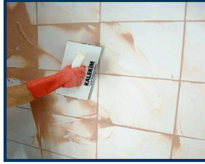
Resim 3.8: Duvarda derz dolgu uygulaması
