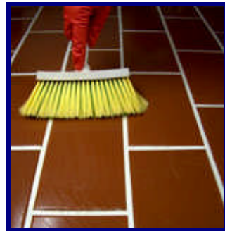
Resim 3.18: Koruyucunun fırça ve saplı fırça ile uygulanması
