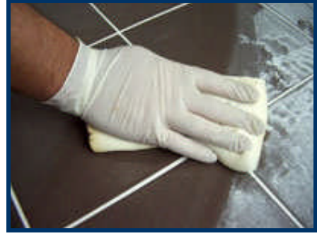
Resim 3.16: Zemin derz dolgu işleminde ilk silme
