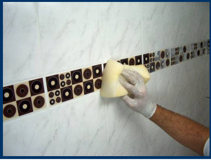
Resim 3.9: Nemli sünger ile ilk silme
