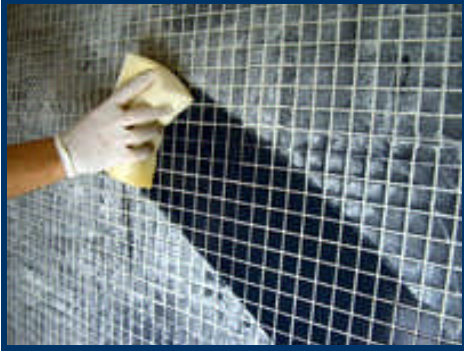
Resim 3.10: Uçuk renk tabakasını tekrar silme ve derzleri oluklandırma
