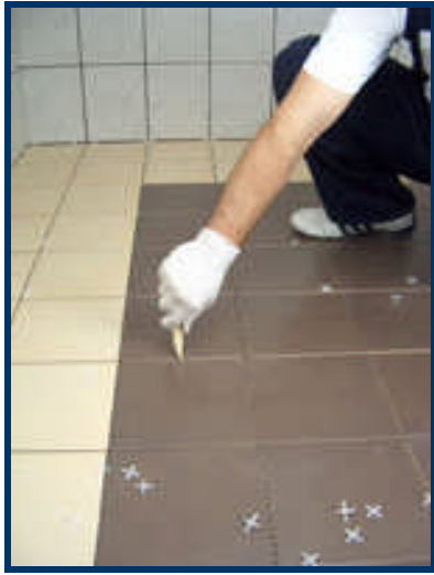
Resim 1.5: Derzlerin zeminde kerpeten, sünger, kama ve fırça ile temizlenmesi
