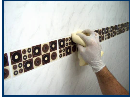
Resim 3.9: Nemli sünger ile ilk silme
