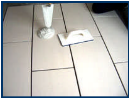
Resim 3.11: Harcın yüzeye konulması
