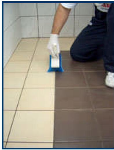
Resim 1.5: Derzlerin zeminde kerpeten, sünger, kama ve fırça ile temizlenmesi
