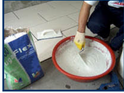
Resim 2.5: Harcın karıştırılması
