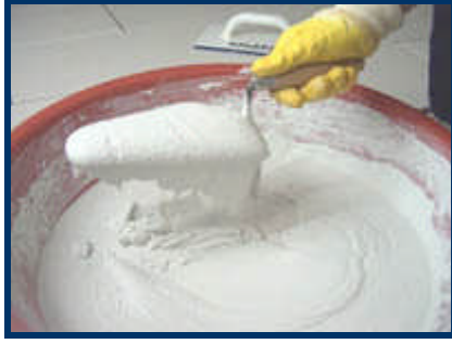
Resim 2.1: Derz dolgu (fuga) harcı kıvamı
