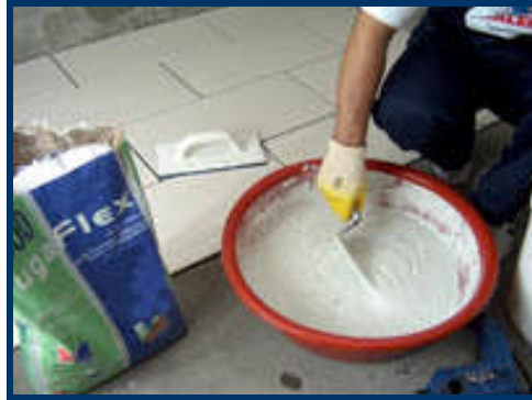
Resim 2.6: Bekletilen harcın alıştırılması
