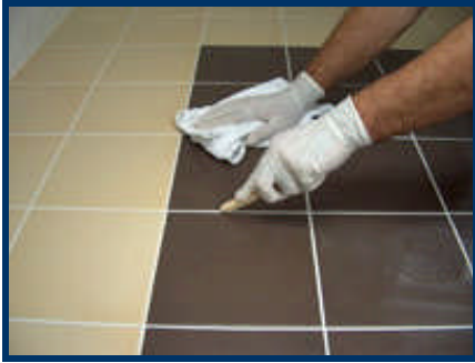
Resim 3.17: Zemin derz dolgu işleminde son silme ve oluklandırma işlemi
