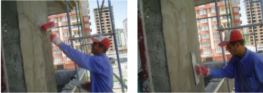
Resim 2.7: Sıvanın ıslatılması ve perdahlanması
