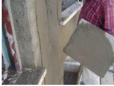
Resim 2.6: İnce sıva harcının düzeltilmesi
