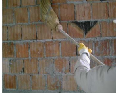
Resim 1.19: Yüzeyin tel fırça ve süpürge ile temizlenmesi
