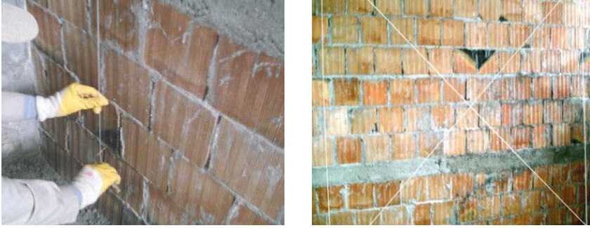
Resim 1.21: Duvara ip çekilmesi
