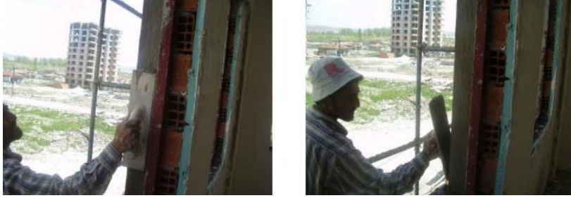
Resim 2.8: Pencere köşelerinin sıvanması
