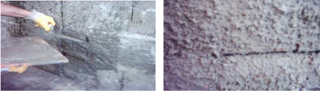
Resim 1.23: Sıva altı serpmeye uygulaması
