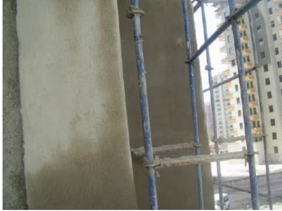
Resim 2.1: İnce sıva yapılmış yüzey
