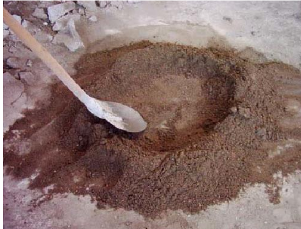
Resim 1.15: Ortası havuz şeklinde açılmış kum
