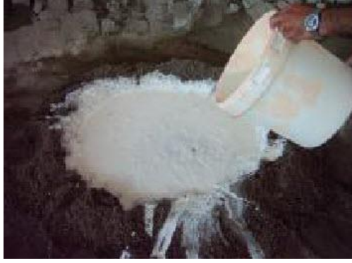
Resim 1.17: Suyun karışıma eklenmesi
