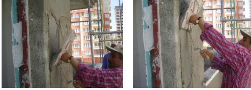
Resim 2.5: İnce sıvanın yüzeye uygulanması
