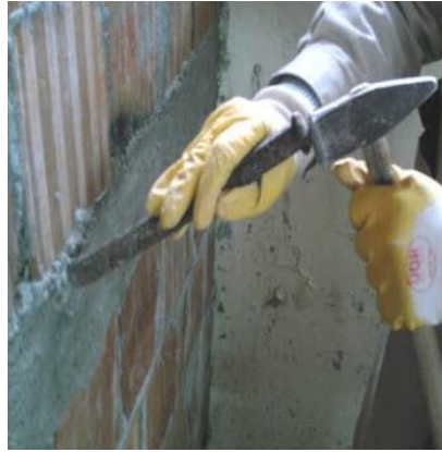
Resim 1.20: Kaba pürüzlerin murç ile temizlenmesi
