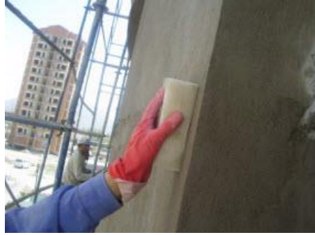
Resim 2.9: Serbest kumların düşürülmesi
