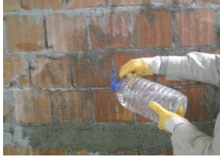
Resim 1.22: Duvarın ıslatılması
