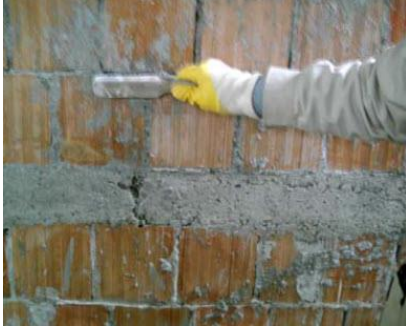
Resim 1.19: Yüzeyin tel fırça ve süpürge ile temizlenmesi
