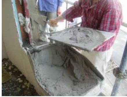
Resim 2.4: İnce sıva harcının tahta mala üzerine alınması
