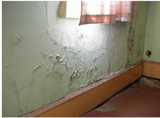
Resim 4.2: Temizlenmesi gereken iç duvar
