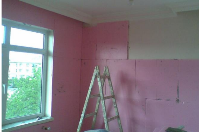
Resim 4.4: Levhaların duvara yapıştırılması
