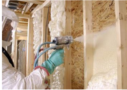
Resim 1.5: Yerinde köpük oluşturan yalıtım malzemesi
