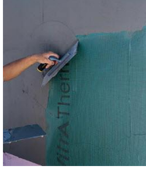
Resim 3.9: Donatı filesinin yerleştirilmesi
