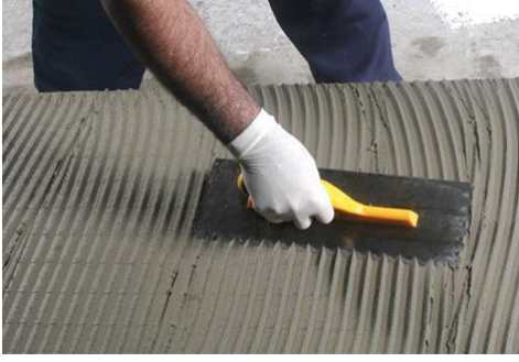
Resim 3.6: Yalıtım levhalarının yapıştırılması
