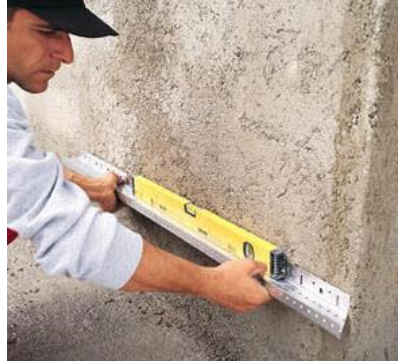
Resim 3.5: Su basman profillerinin yerleştirilmesi
