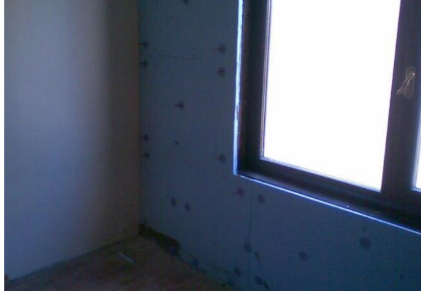
Resim 4.5: Yapıştırma sonrası dübelleme
