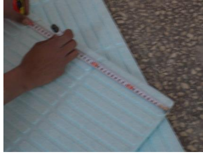
Resim 1.8: Yalıtım malzemesinin işaretlenmesi
