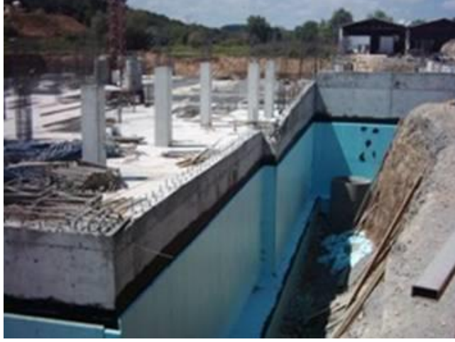
Resim 1.15: Yalıtımı tamamlanmış toprak temalı perde duvarlar
