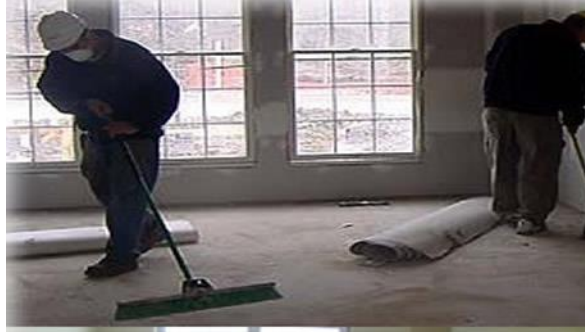
Resim 2.4: Yalıtım yapılacak yüzey temizliği
