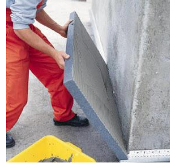
Resim 3.6: Yalıtım levhalarının yapıştırılması
