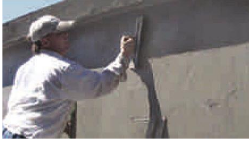
Resim 3.4: Yüzeyin düzeltilmesi
