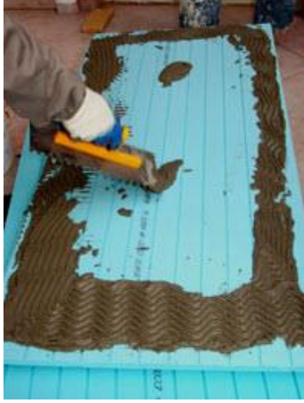
Resim 4.3: Yapıştırma harcının uygulanması
