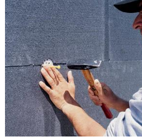
Resim 3.7: Dübelleme şeması ve dübelleme işlemi
