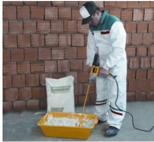
Resim 1.12: Yapıştırma harcının karıştırılması
