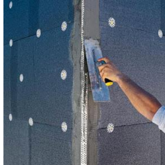
Resim 3.8: Köşe profillerinin yerleştirilmesi
