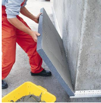
Resim 1.2: Dış duvar ısı yalıtımı uygulaması
