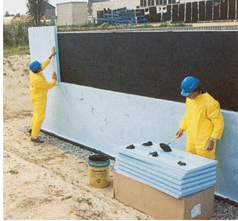
Resim 1.14: Yalıtım levhalarının döşenmesi
