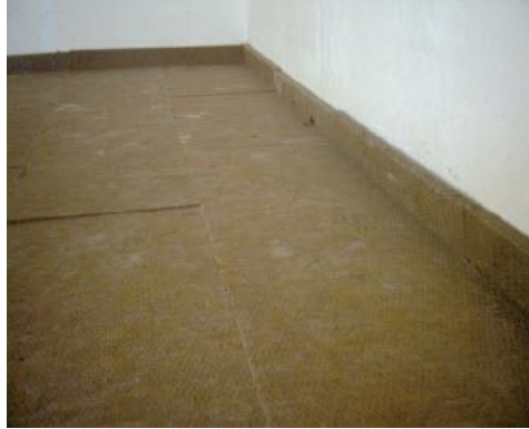
Resim 2.5: Serbest olarak yerleştirilmiş ısı yalıtım malzemeleri
