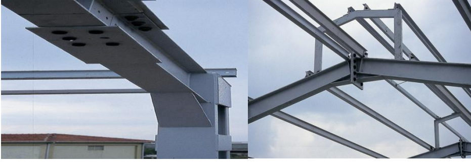
Resim 1.4: Çelik yapı birleşim noktaları Resim 1.5: Çelik yapı birleşim noktaları
