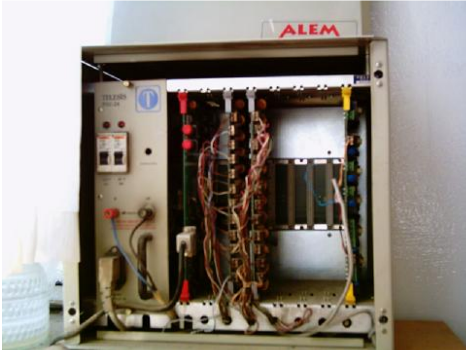
Resim 3.1: Telefon santrali iç yapısı.
