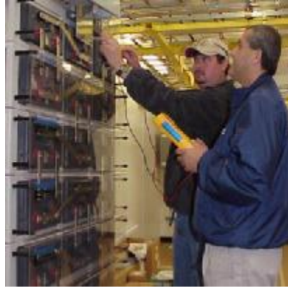
Resim 2.3: Telefon santralinde ölçme
