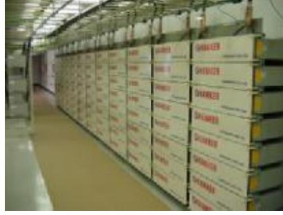
Resim 2.1: Telefon santralinden bir görünüm
