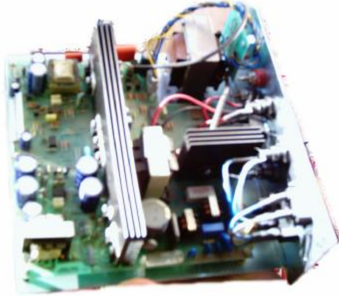
Resim 3.2: Telefon santrali besleme ünitesi
