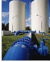
Resim 2.7: İçme suyu arıtma tesisi
