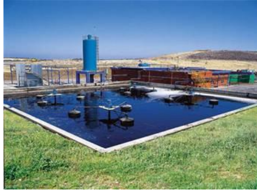
Resim 1.3: Sızıntı suyu tesisi
