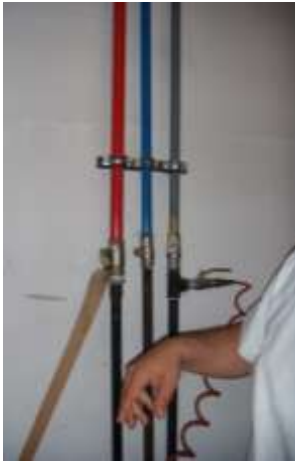
Resim 1.9: Kompresör, filtreler, kompresör kurutma ve şalümolara sistemin gelişi
