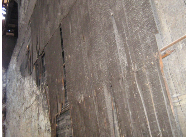
Resim 2.6: Duvarları zift emdirilmiş tahtalarla kaplanmış amonyum sülfat deposu
