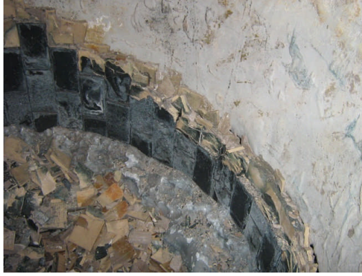
Resim 1.9: İçi aside dayanıklı tuğlalarla örülü şerbet tankı
