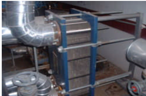
Resim 1.4: Kızgın su tesisatında kullanılan plakalı bir ısı eşanjörü
