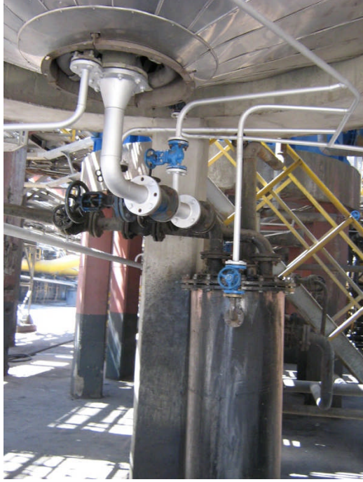
Resim 1.3: Elektrofiltrelerin tabanında biriken katranın tanka sevk edilmesi
