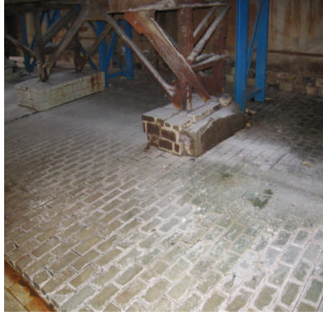
Resim 2.3: Amonyum sülfat tesisleri zemini (aside dayanıklı tuğlalarla örülü)
