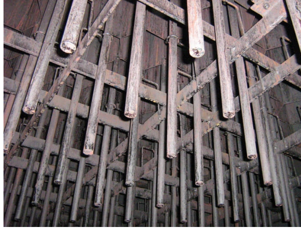
Resim 1.1: Elektrofiltrede elektrotlar
