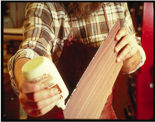
Resim 1.5:Alınlara tutkal sürülmesi
