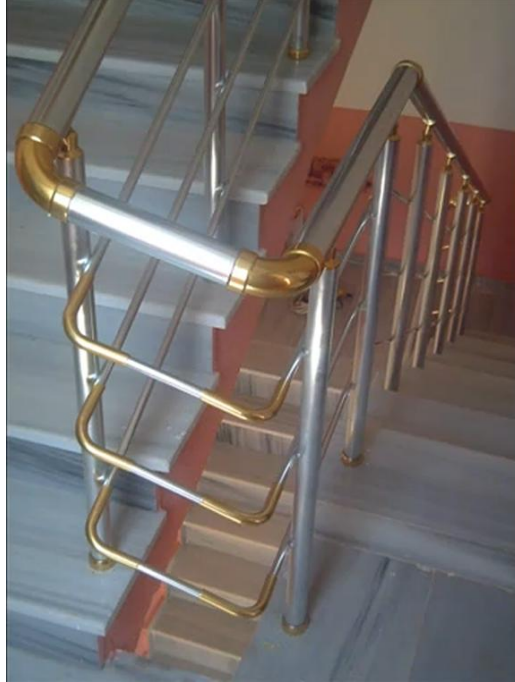
Fotoğraf 2.8: Montaj sonrası merdiven korkuluđu
