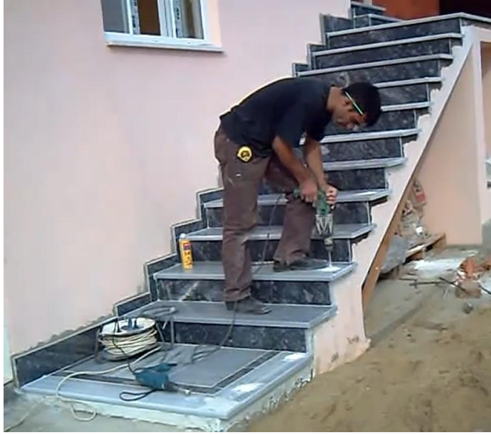
Fotoğraf 2.3: Ankaryaj deliklerinin açılması işlemi
