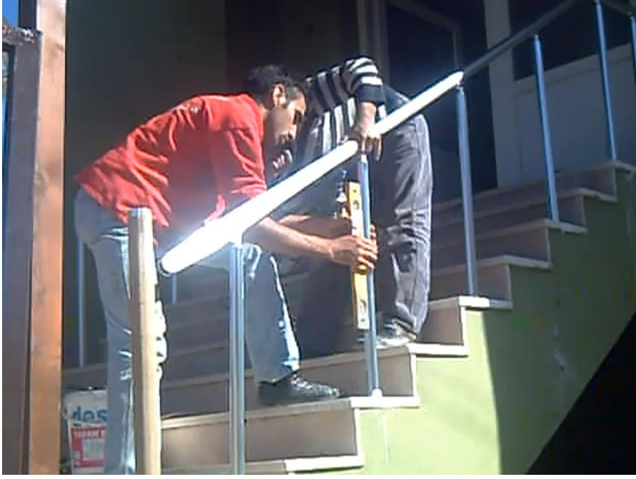
Fotoğraf 2.7: K peşte montajı
