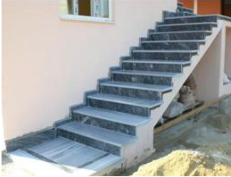
Fotoğraf 2.2: Alüminyum merdiven korkuluğu yapılmadan öncesi
