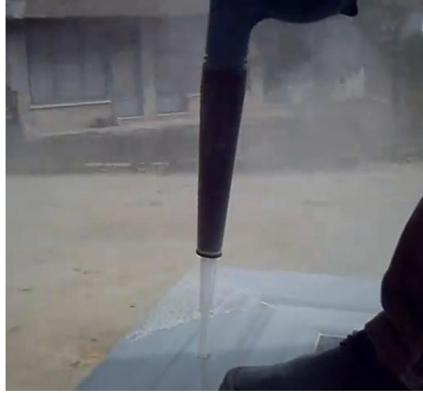
Fotoğraf 2.4: Üfleme makinesi ile deliklerin temizlenmesi
