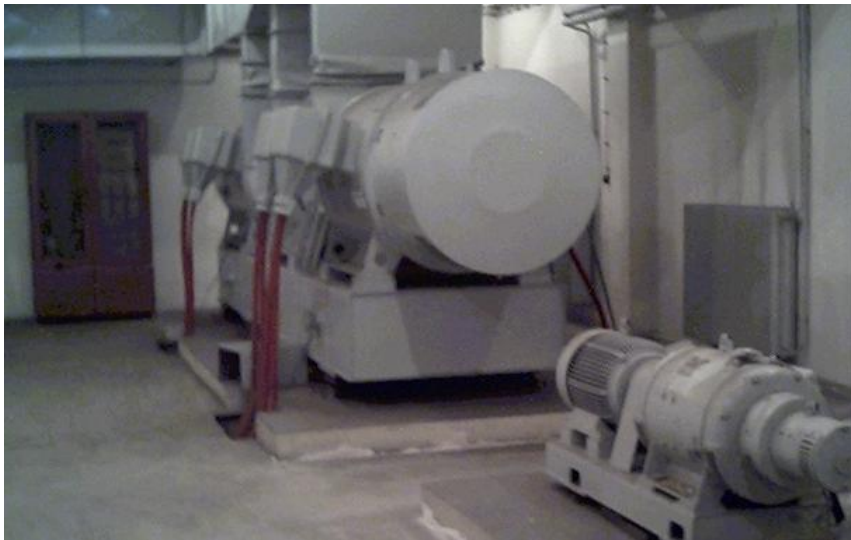
Resim 2.2: Birbirine akuple bağlı jeneratör ve motor
