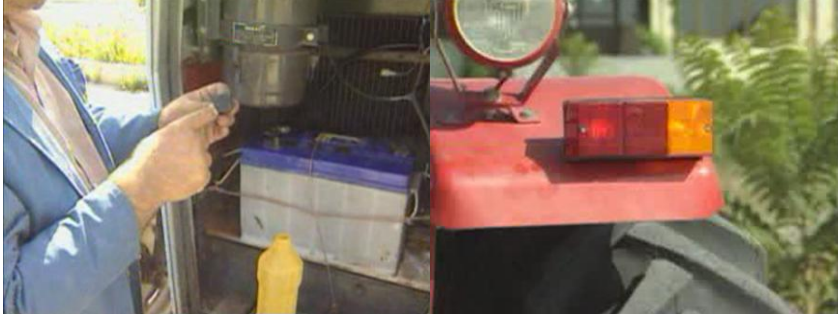
Resim 1.13: Elektrik donanımının kontrolü
