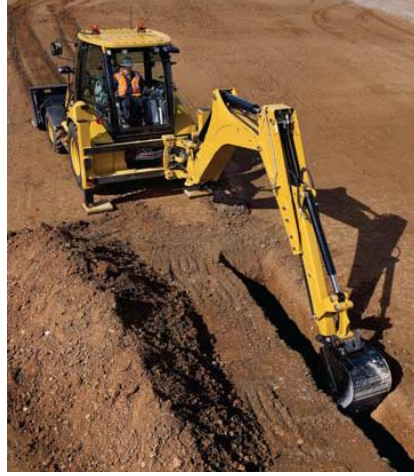
Resim 1.13: Kanal kazma çalışması
