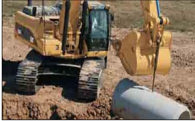
Resim 1.4: Kanal çalışması yapan paletli ekskavatör
