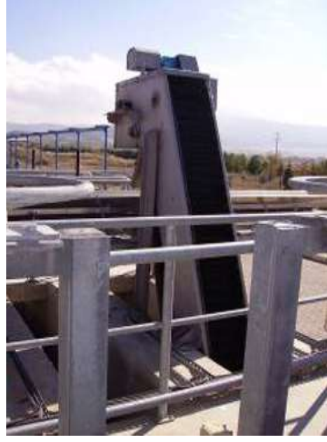
Resim 2.5: İnce ızgara kanalı
