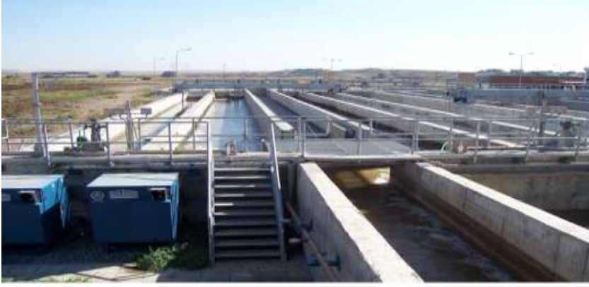
Resim 2.6: Kum ve yağ tutucular
