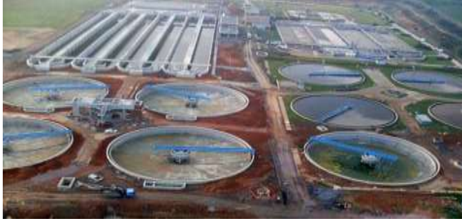
Resim 2.1: Atık su arıtım tesisi
