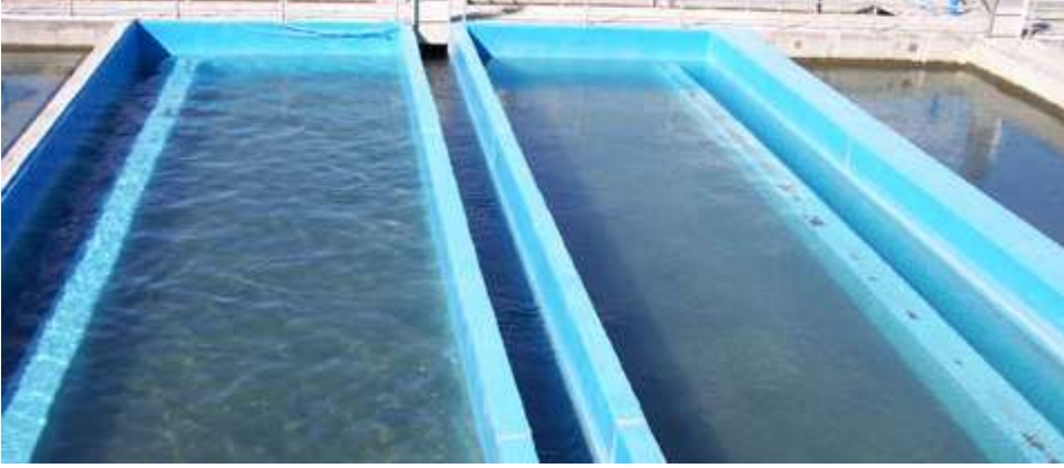
Resim 2.14: Filtrasyon havuzu
