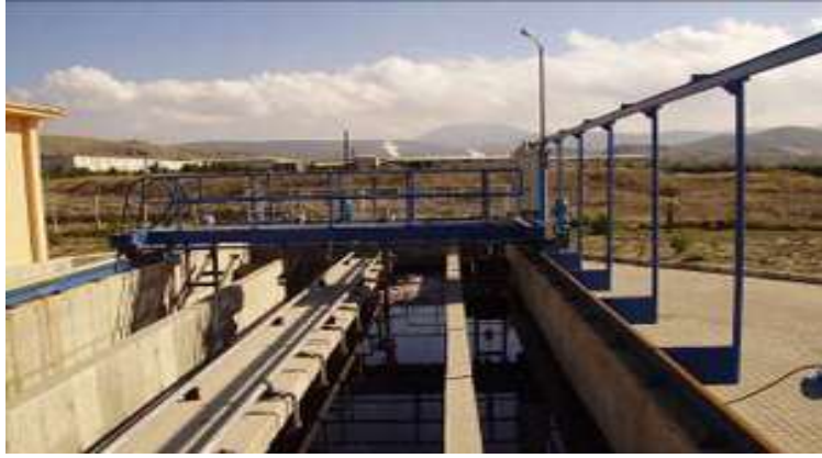
Resim 2.5: Havalandırılmalı kum tutucular
