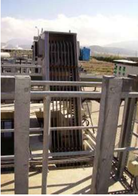
Resim 2.4: Kaba ızgara kanalı
