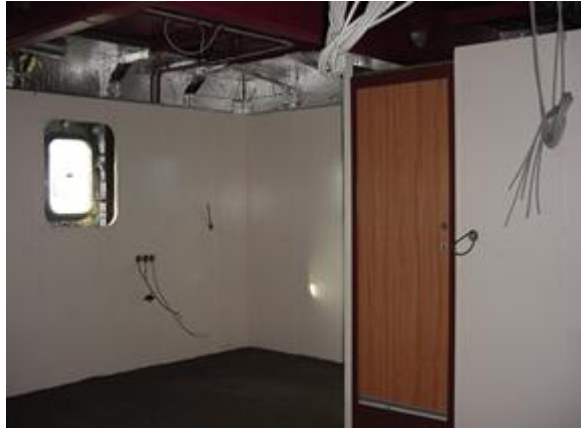
Resim 2.1: Yaşam mahalli izolasyon çalışması
