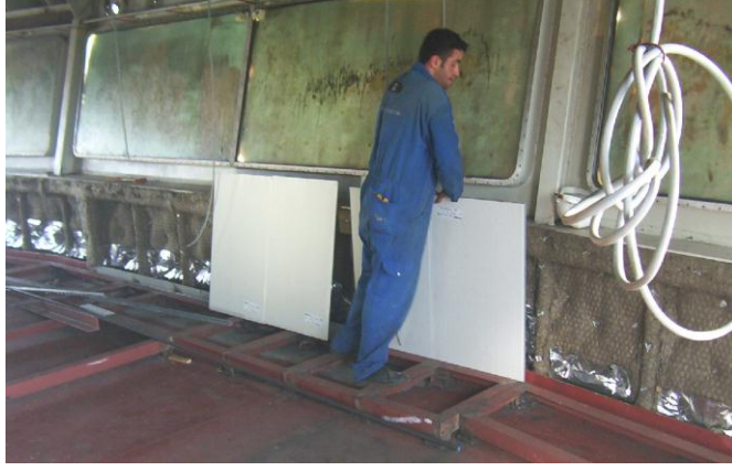
Resim 1.3: Kaptan köşkü yalıtım çalışması
