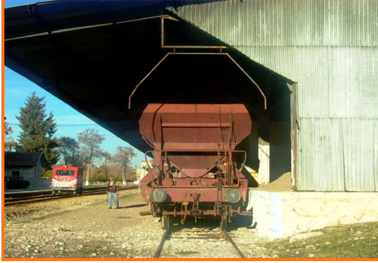
Resim 2.2: Gabari tesisi 2
