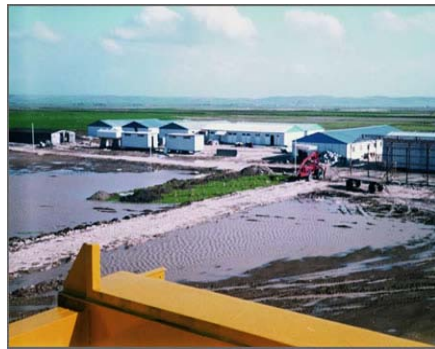
Resim 1.5: Prefabrik şantiye tesisleri
