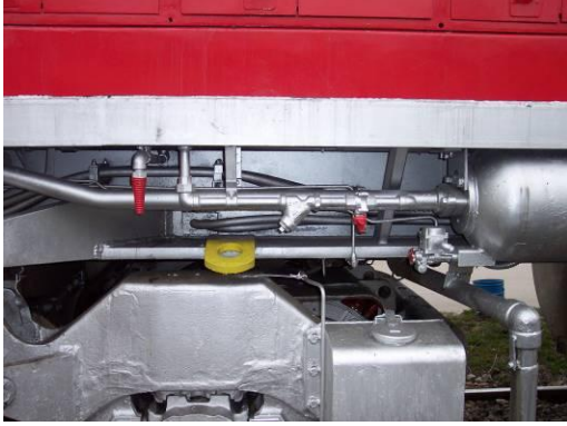
Resim 1.5: Ana hava deposu tahliyesi
