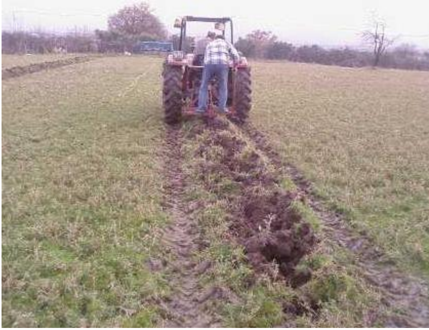
Resim 2.3: Dip kazan çekilmesi
