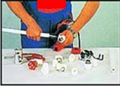
3. Boru ve ek parçasının ısıtılması
