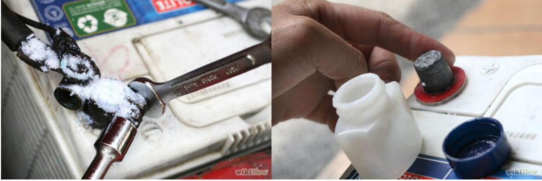
Resim 2.4: Oksitlenmiş bir bataryada kablo pabucunun sökülmesi ve temizlik sonrası
