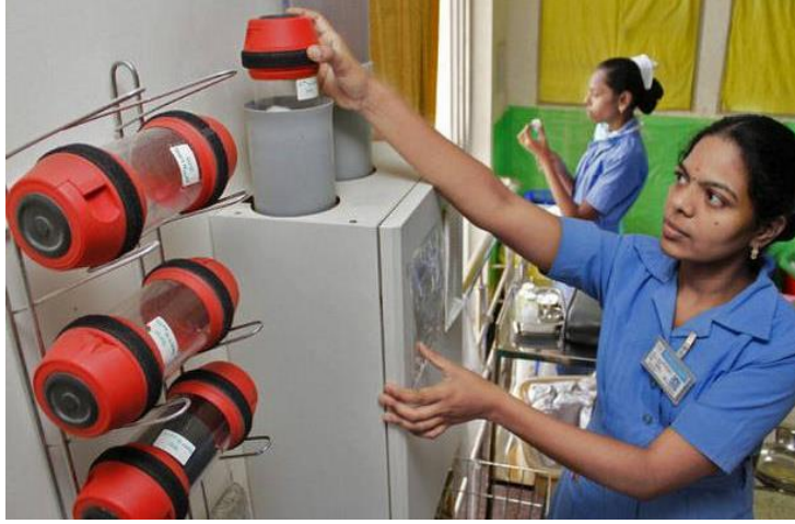
Resim 2.3: Pnömatik taşıma sistemi
